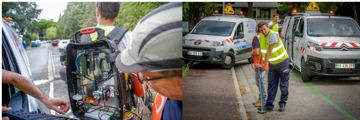
Photos : Recherche de fuites au gaz traceur à Marseille en partenariat avec Veolia Lyon
