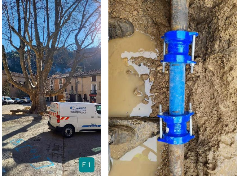
Photos : Détection d'une fuite invisible puis réparation
