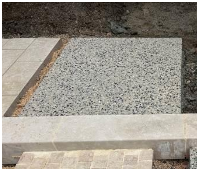
Figure 1 : bordure calcaire et revêtement parvis
