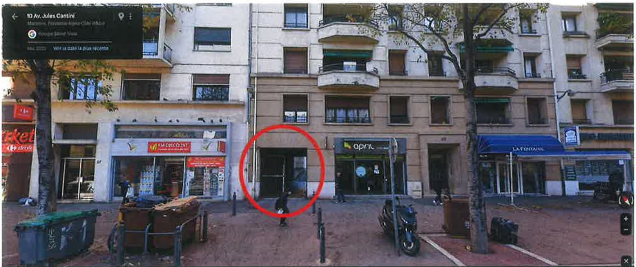
Accès véhicule n°1 à condamner et à transformer en accès piétons
