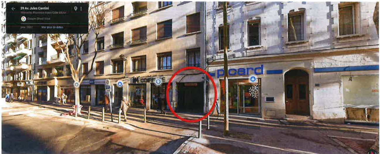
Accès véhicule n°2 à conserver, portail à remplacer
