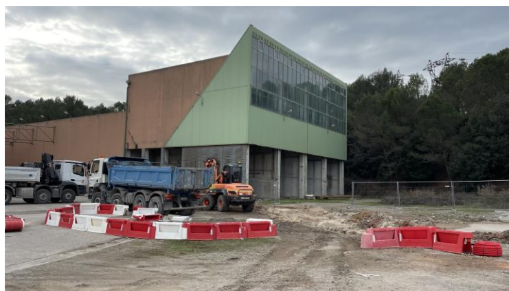
Figure 4 : Travaux de viabilisation du lot 8
