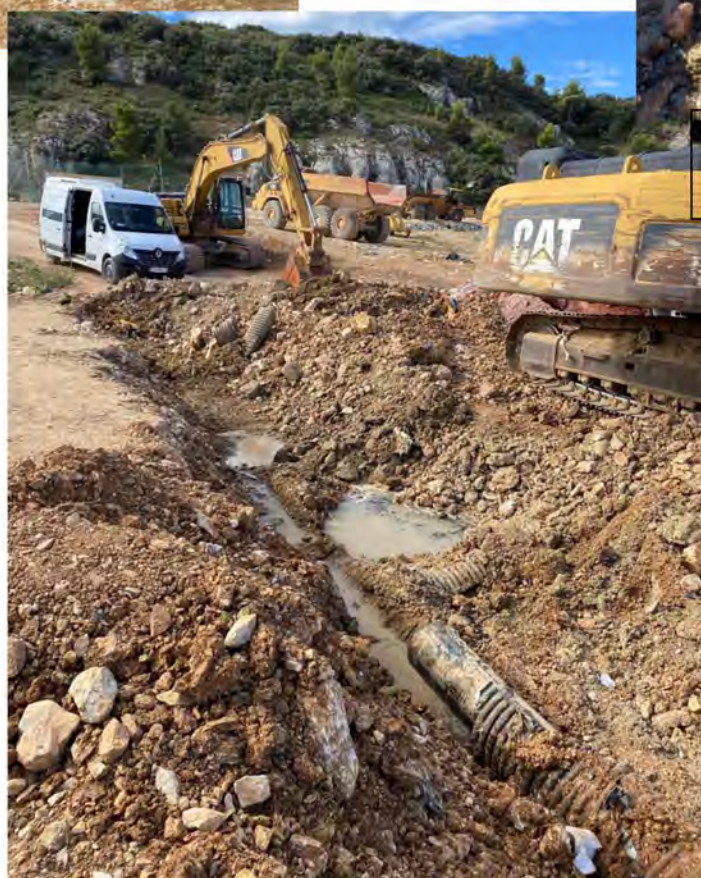
Travaux collecteur biogaz au niveau de la traversée de piste
