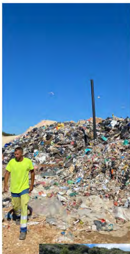
Réhausse des puits
