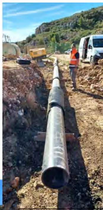
Travaux collecteur biogaz au niveau de la traversée de piste
