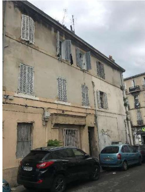
Des travaux de confortement structurel provisoire ont ensuite été exécutés et terminés en 2022 dès lors qu'Urbanis Aménagement est devenue propriétaire unique de l'immeuble. Les travaux ont permis l'étalement des planchers, une réfection de la toiture et de la cage d'escalier, la reprise des chutes d'eaux pluviales en façade et le traitement du soubassement dégradé des murs de la cave.
