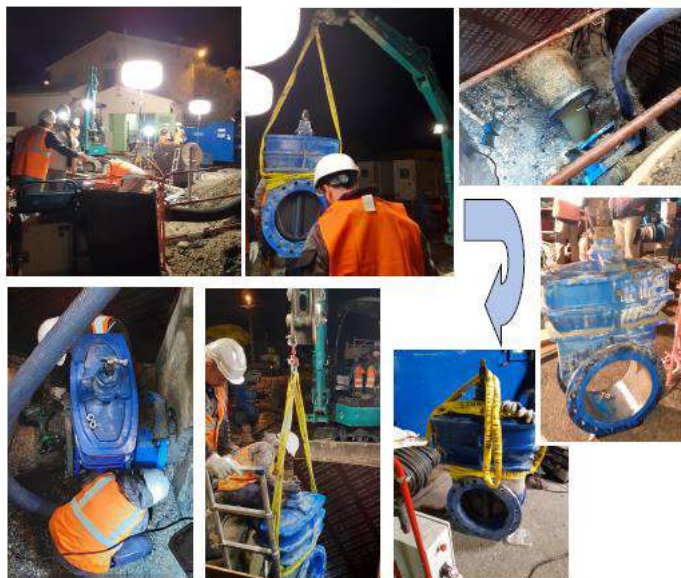
Remplacement de la vanne d'isolement du refoulement après vidange de la conduite. Evacuation de l'ancienne vanne et remise en service du poste de relevage après déconsignation électrique.
