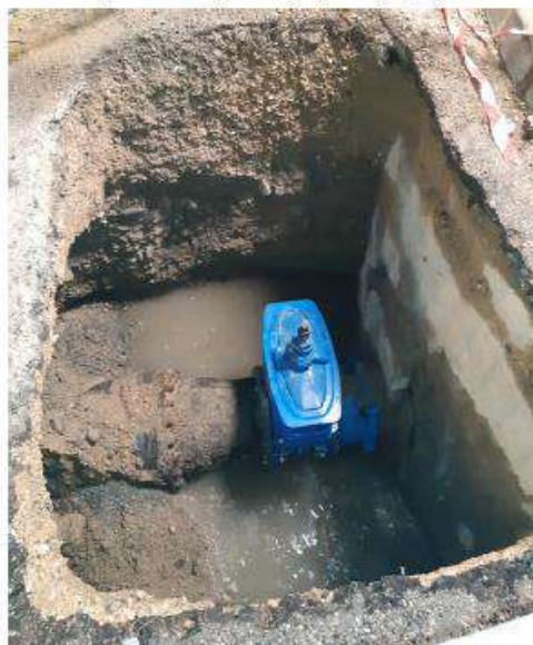
Remise en service du poste de relevage, évacuation des déblais de chantier et remblaiement de la fouille
