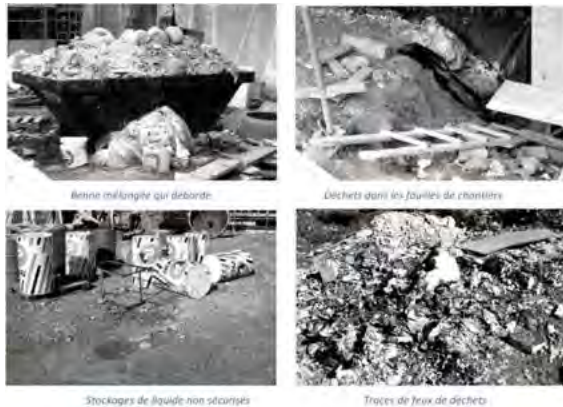
Figure 82 : Exemples de gestion non appropriée des déchets de chantier
