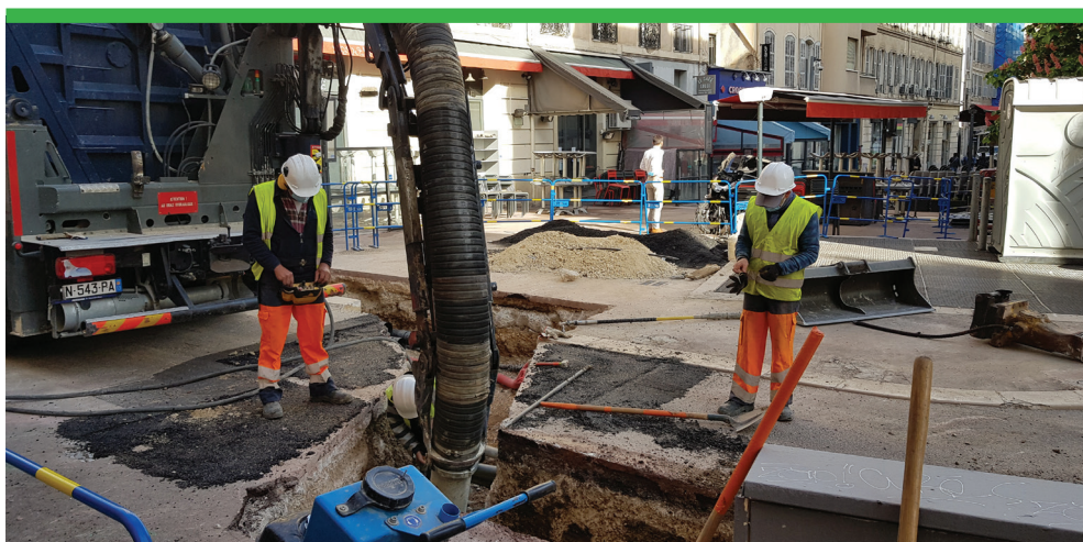
Travaux de sécurisation et de modernisation dans la rue Grignan à Marseille.
