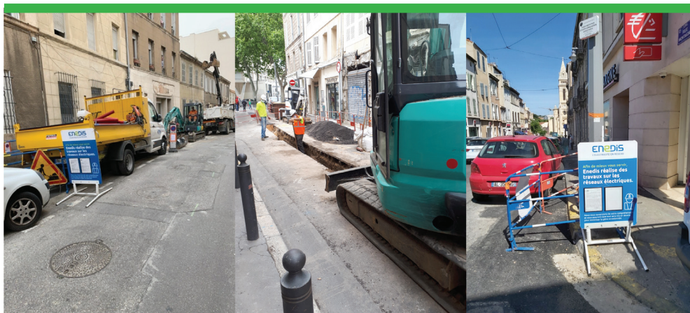
Renouvellement du réseau électrique souterrain Basse Tension du Boulevard Boisson (4ème), de la Rue Vacon (1er) et de la Rue Montaigne à Saint Barnabé (12ème)
