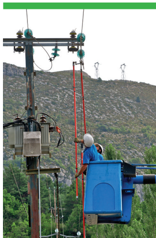
Pose d'isolateurs Avifaune dans les Bouches-du-Rhône
