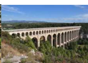
Aqueduc de Roquefavour Ventabren
