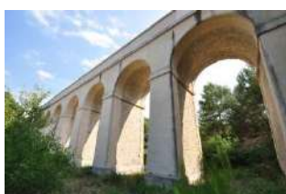
Aqueduc Jacourelle La Roque-d'Anthéron
