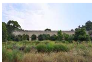
Aqueduc Valbonnette Charleval
