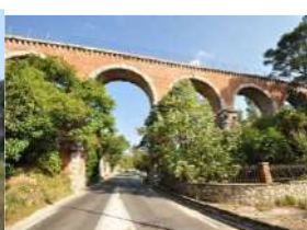
Aqueduc de la Clue Marseille
