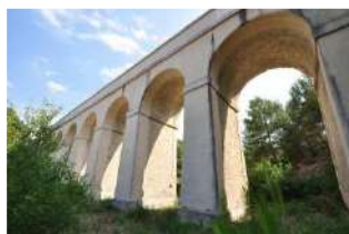
Aqueduc Jacourelle La Roque d'Anthéron
