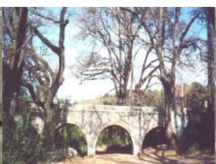
Aqueduc des Lignières Aubagne
