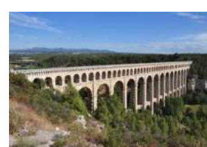
Aqueduc de Roquefavour Ventabren
