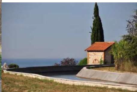
Canal de Marseille
