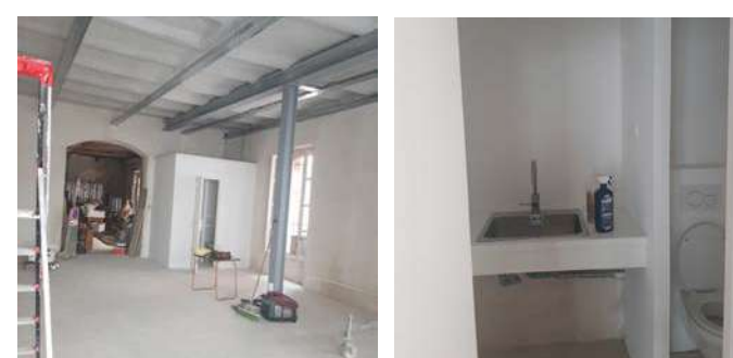
Après travaux - locaux UA
