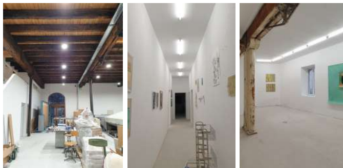
Après travaux - locaux municipaux
