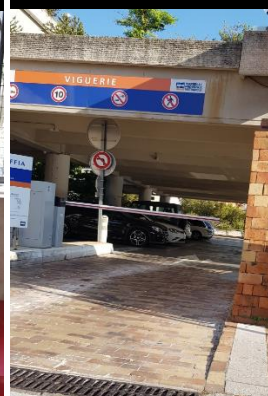
Reprise des pavés, entrée niveau C
