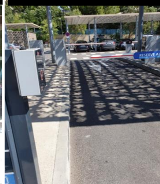
Installation d'une borne pour abonnés
