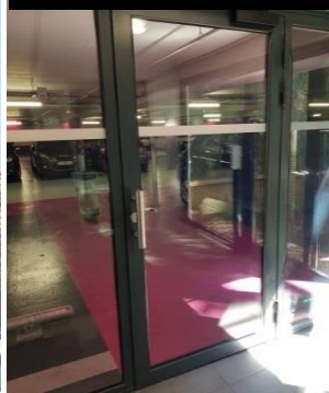
Poignées et serrures portes remplacées
