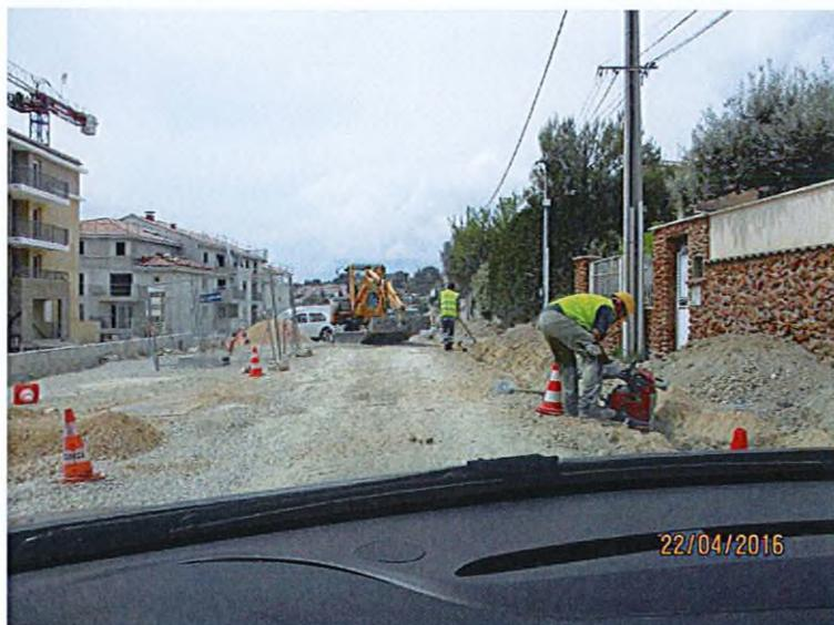
Lors des travaux de terrassements sur la montée de Gardanens par RAZEL BEC, la HT (posée par Innovtec) est à une profondeur par endroit non conforme aux plans fournis avant le lancement des travaux. Mr Plotala présent ce jour (09/06/16) en réunion s'engage à reprendre le réseau dès le lendemain entre les profils 111-1 et 113-1.
