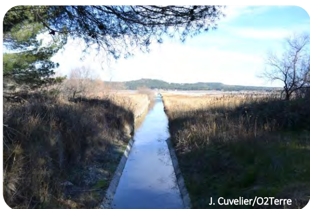
FIGURE 7 : SORTIE CONDUITE CHARLEVAL
