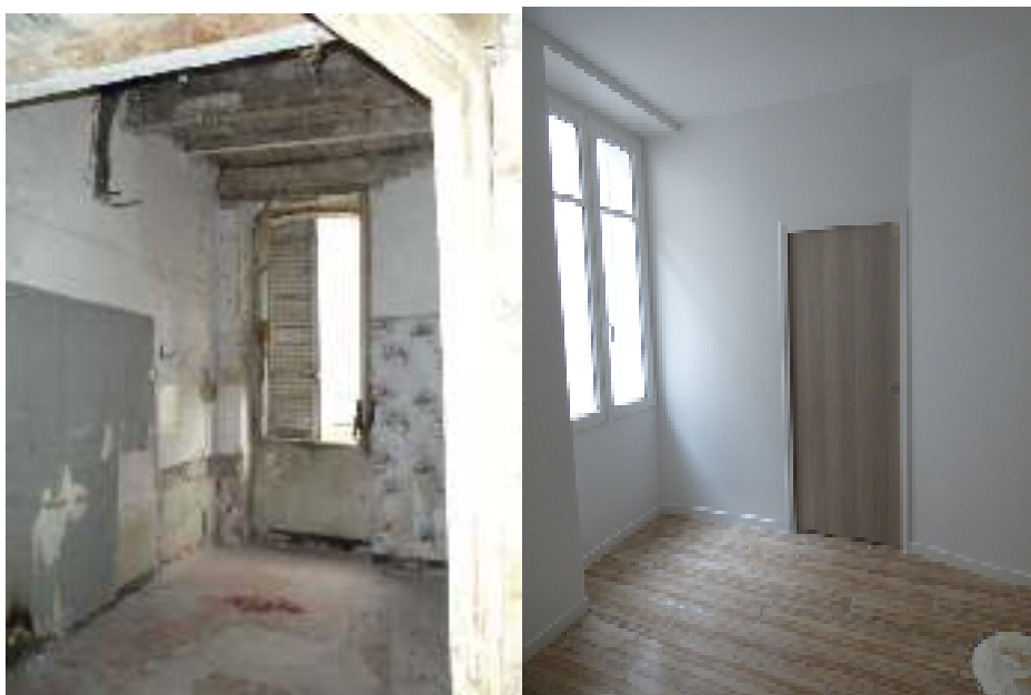
Immeuble situé 17, rue du Musée (1 er ) – vendu avec cahier des Charges en 2016 Avant / après travaux
