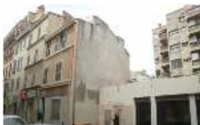
L'immeuble situé 10, rue des Vignerons - 6°
