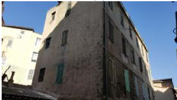
Immeuble situé 4, rue Delui (2°)
