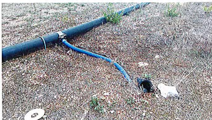
*"bricolage d'un "collier de prise en charge PeHD collé" (impossibilité de capter les condensats) + ouverture du pot de purge à l'air (risque d'entrée d'éléments étrangers pouvant bloquer la purge, risque d'échange avec l'air atmosphérique → odeurs)*
