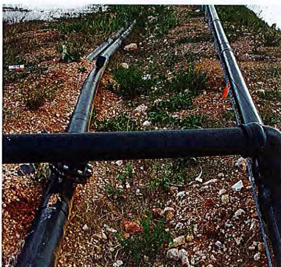
Concernant l'ancienne décharge, vu son ancienneté celle-ci est plutôt bien équipée et l'état du réseau est correct, il faut là aussi reprendre quelques flashes, changer quelques bergaspire brûlés par les intempéries, optimiser quelques étanchéités de tête de puits.
