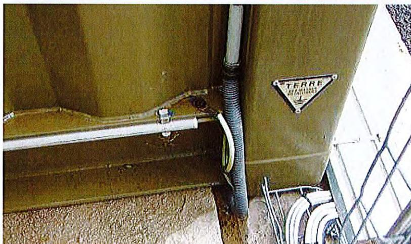
Photos 2 – Mises à la terre des poteaux support des plateformes cheminées.
