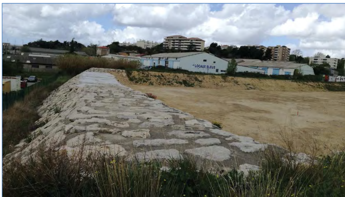
Vue de la lame de surverse du bassin de la Parette
