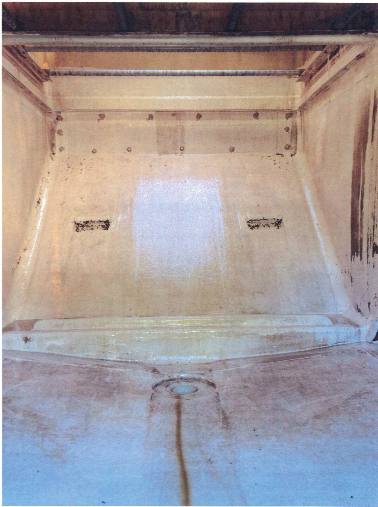
Vue des modules après lavage complet au karcher.
