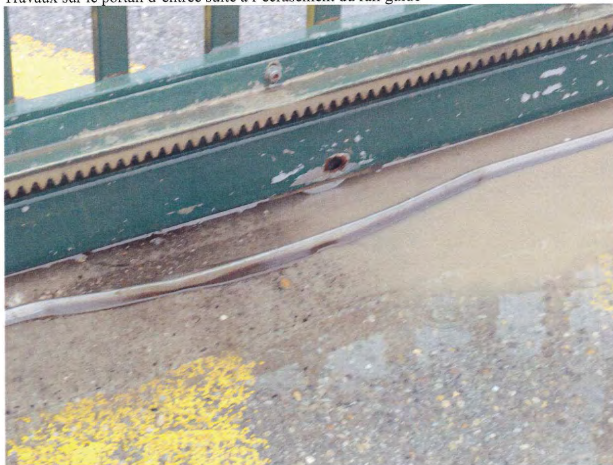
Travaux sur le portail d'entrée suite à l'écrasement du rail guide
