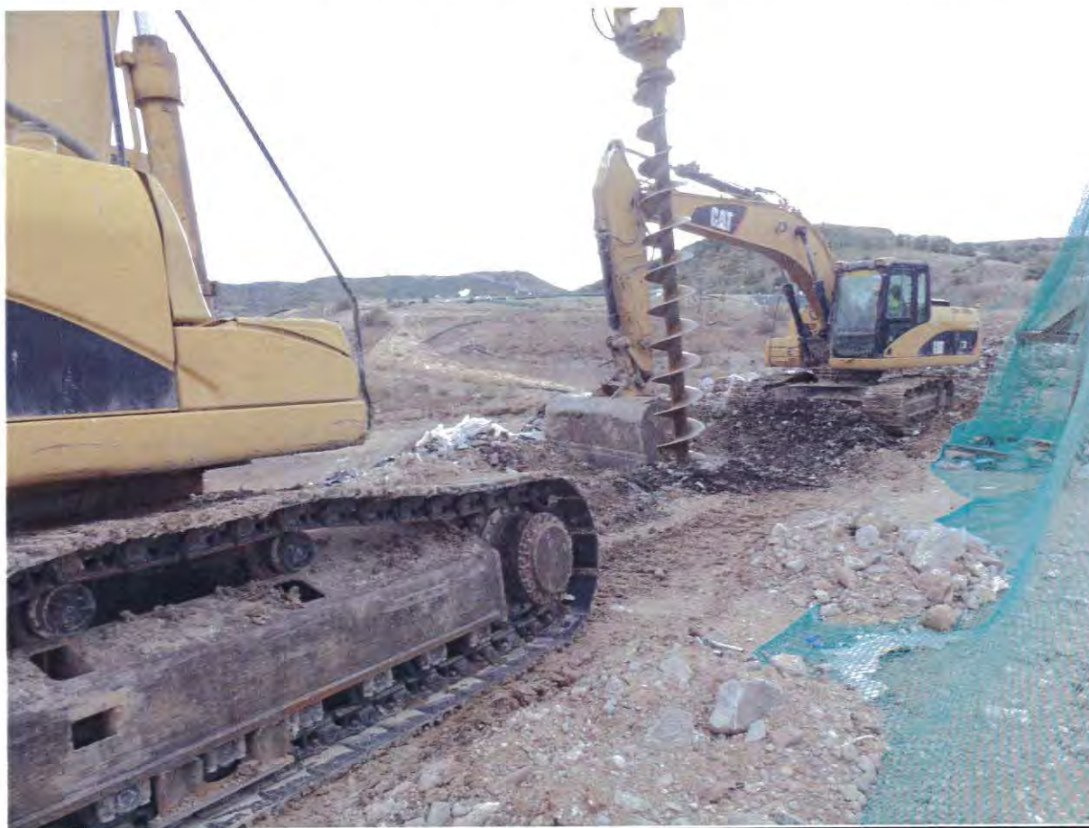
Forage d'un puit
