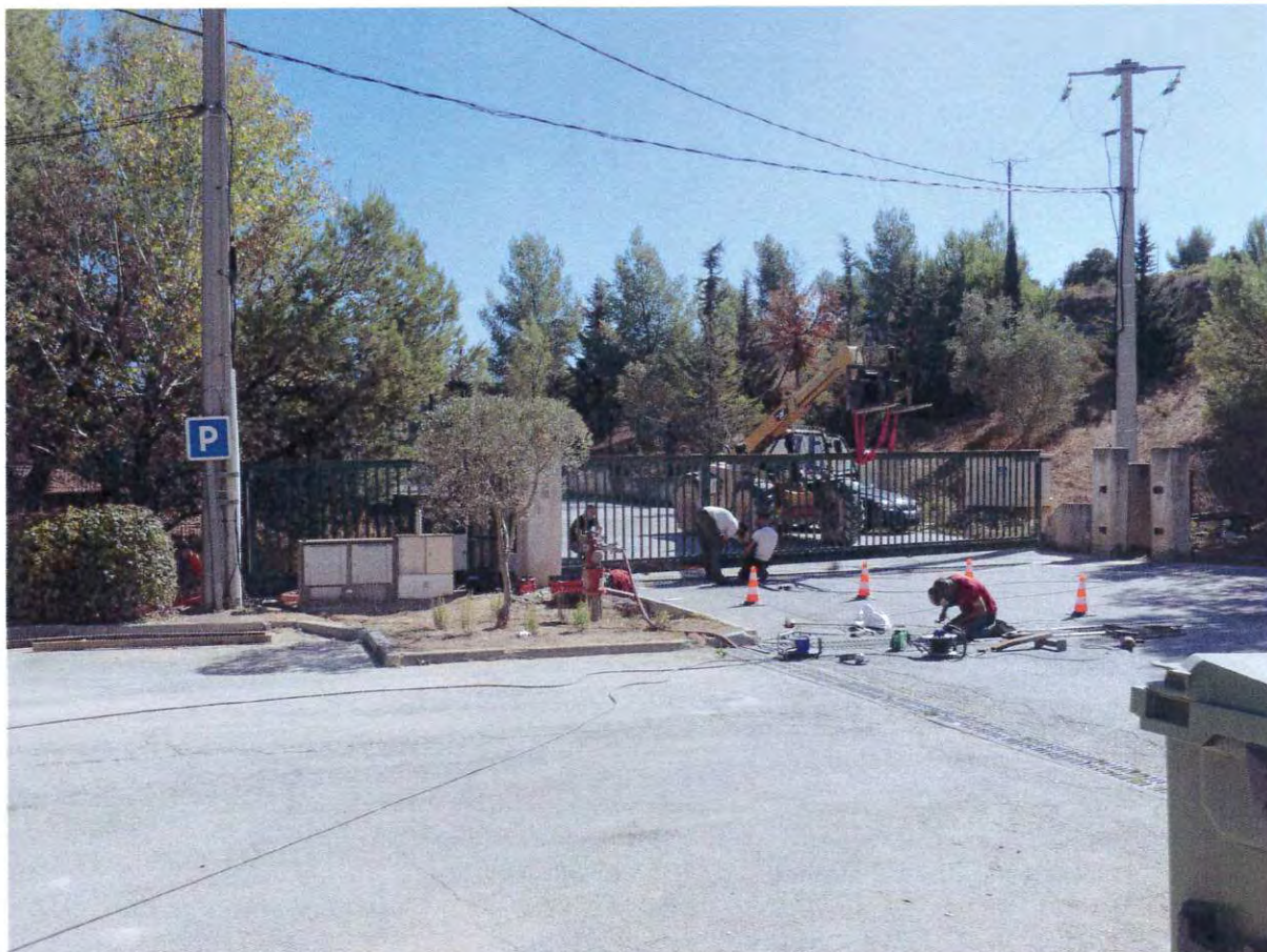
Travaux sur le portail d'entrée suite à l'écrasement du rail guide
