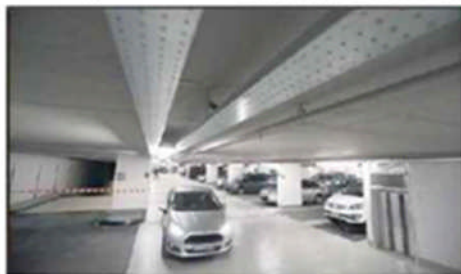
Encore en travaux, un seul étage a été ouvert
