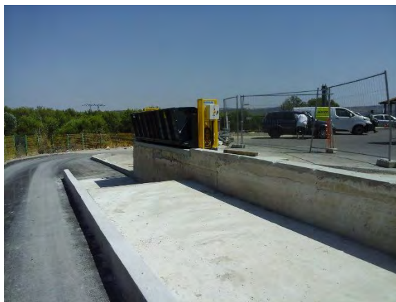
Quai gravat de la déchèterie de Rognac
