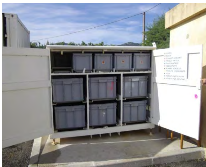
Récupération des DDM déchèterie de Cuges-les-Pins
