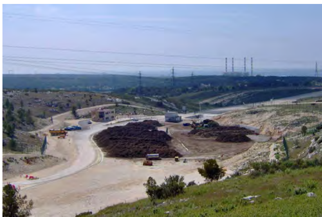
Plateforme de compostage en exploitation
