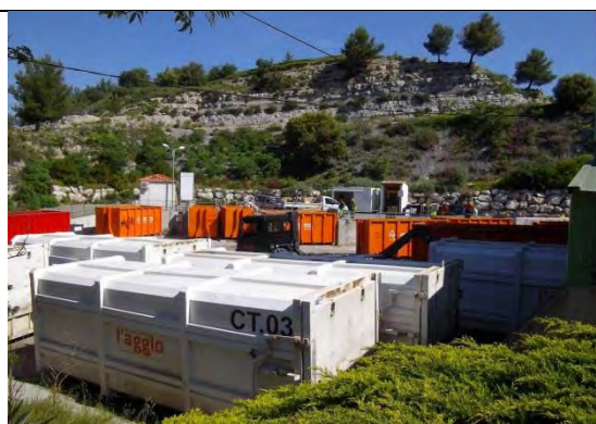
Déchèterie de Peypin
