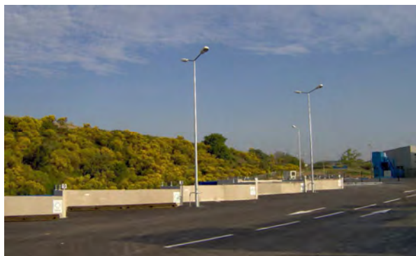
Quais – Déchèterie de Croix-Sainte
