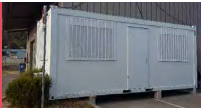
POSE D'UN BUNGALOW NEUF SUR LA DÉCHÈTERIE DE L'AVON À GARDANNE.
