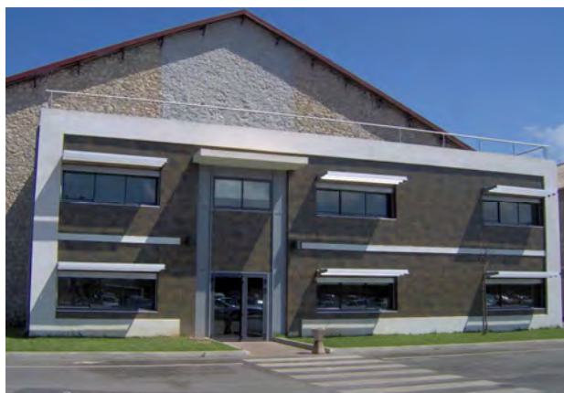
Bâtiment exploitation du service
