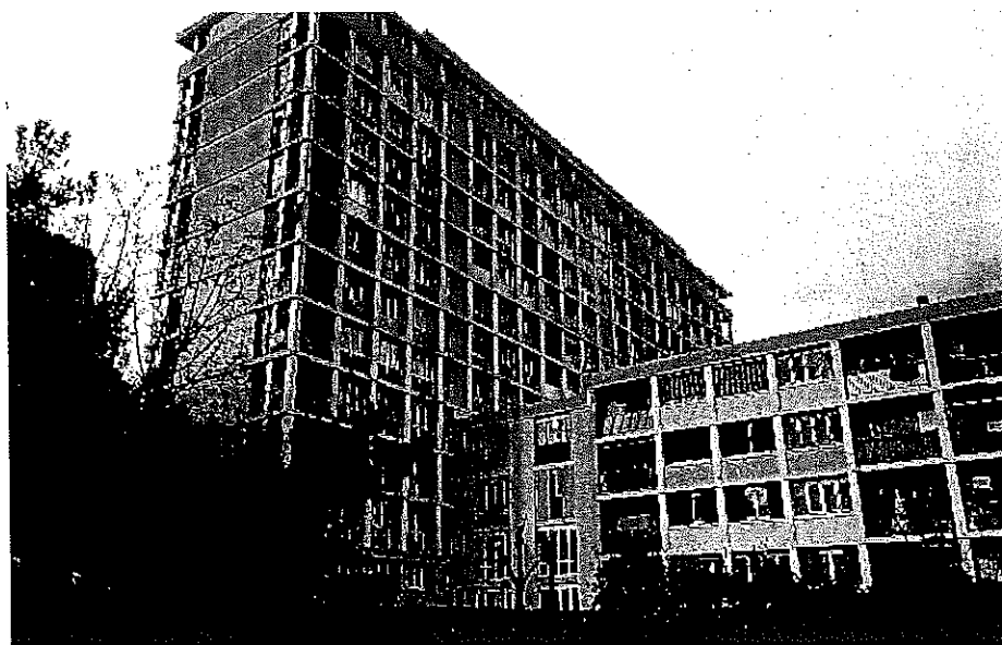
Résidences Plombières 27 boulevard de la Révolution 13003 Marseille
