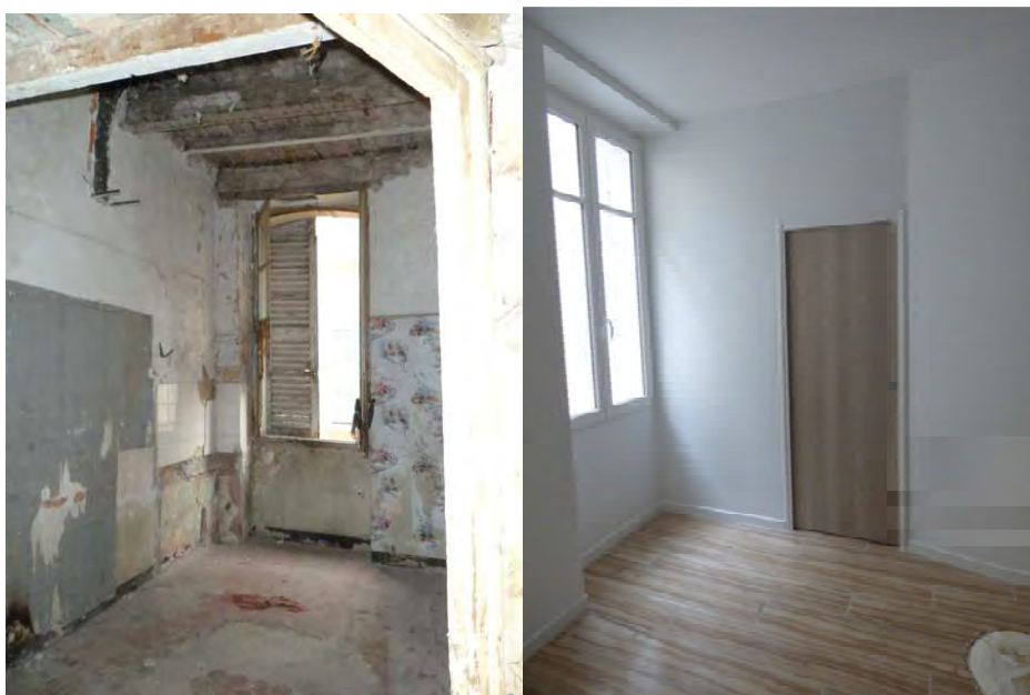
Immeuble situé 17, rue du Musée (1°)– vendu avec cahier des Charges en 2016 Avant / après travaux
