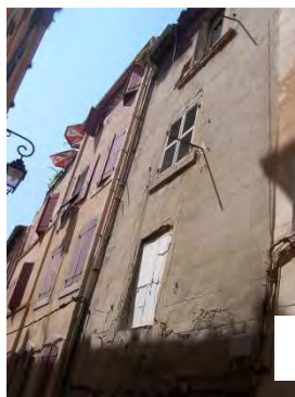
Immeuble situé 4, rue Porte Baussenque – (2 e ) –
