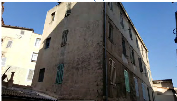
Immeuble situé 4, rue Delui (2°)
