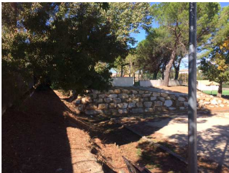
Les enrochements réalisés
