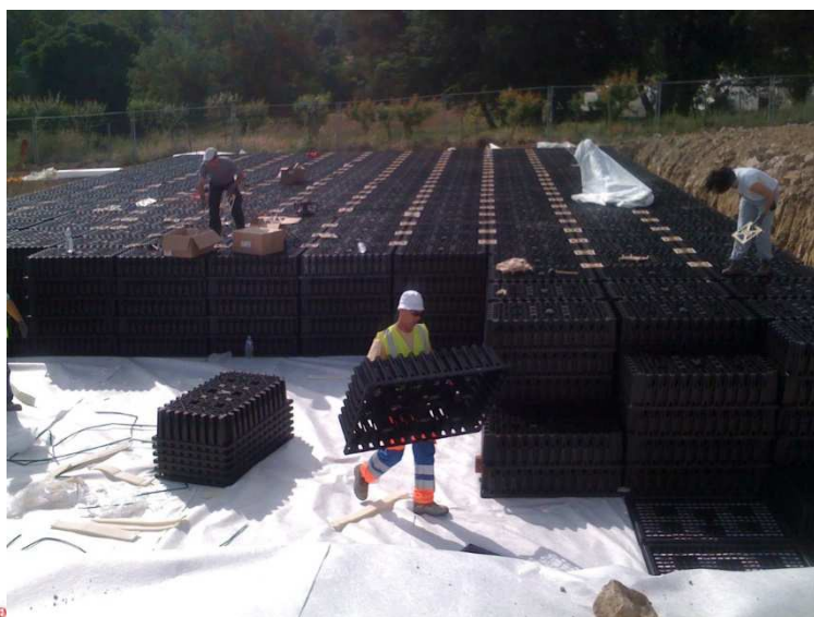
Aménagement du bassin de retention et du terrain de pétanque en superstructure
