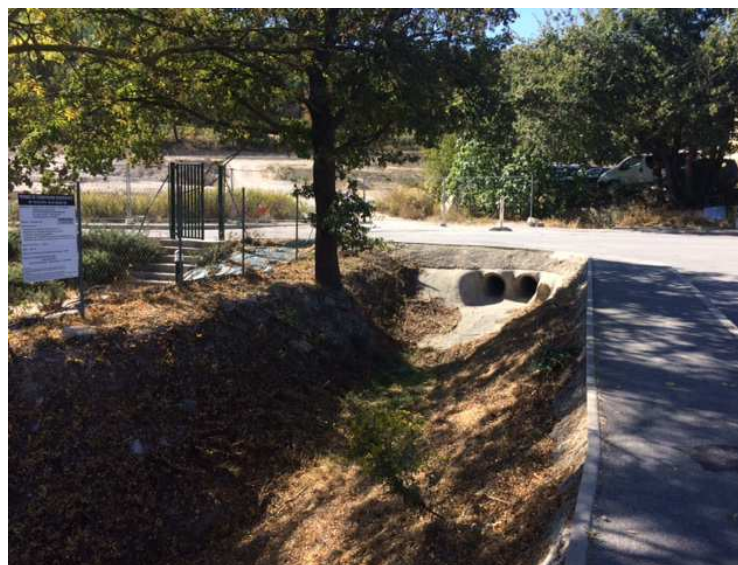
Le thalweg, après aménagements et busage partiel
