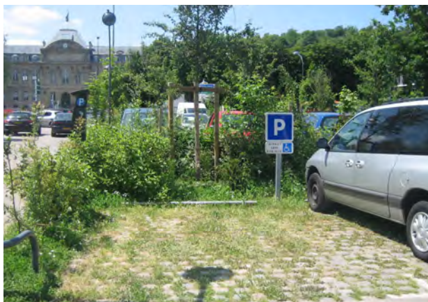
Stationnement de véhicules au sol perméable
