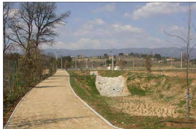
Voie d'entretien et bassin de rétention
