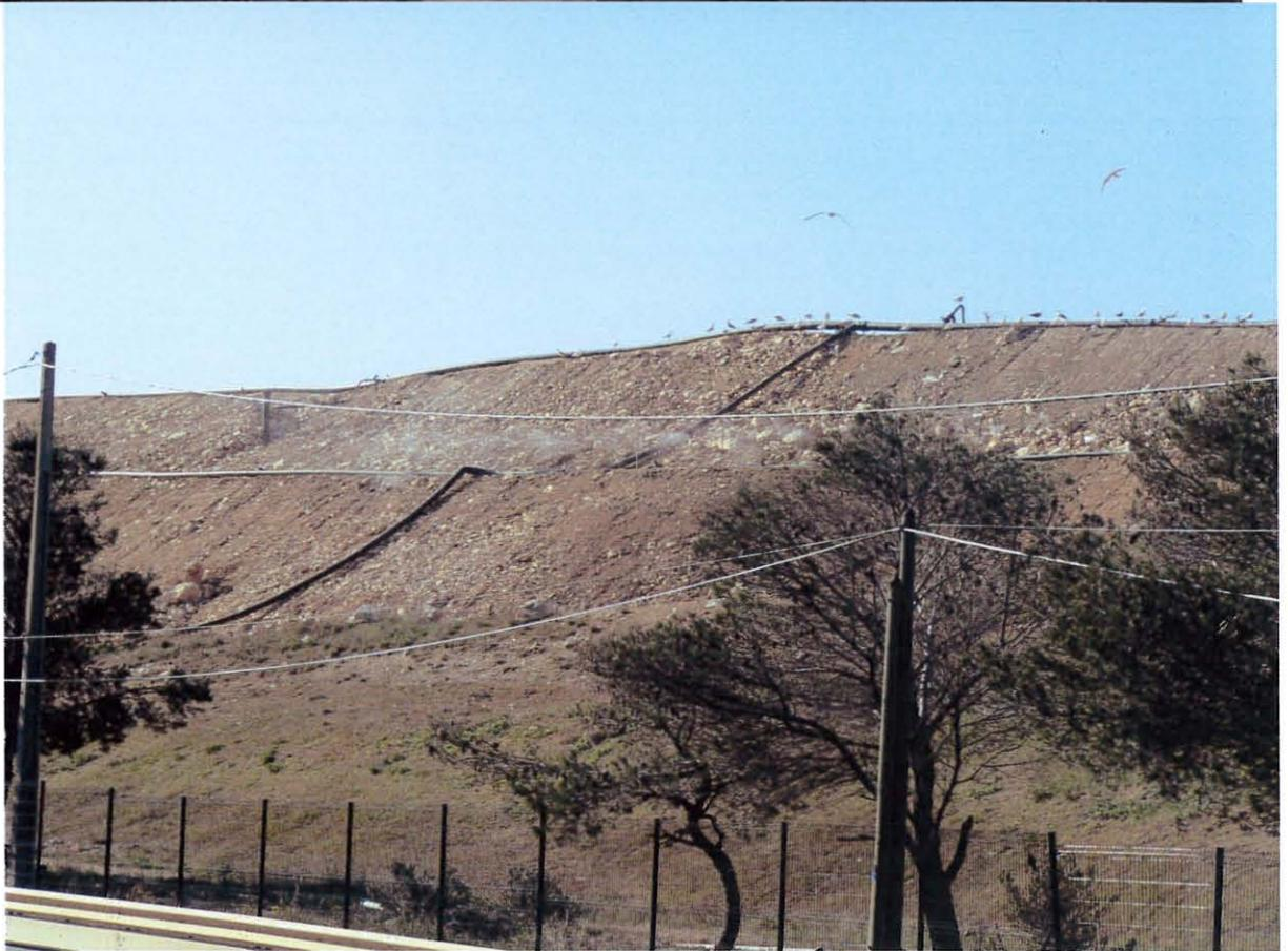
Les zones d'exploitation en latence ont été recouvertes de terre et d'argile et seront découvertes au fur et à mesure de l'avancée de l'exploitation.
