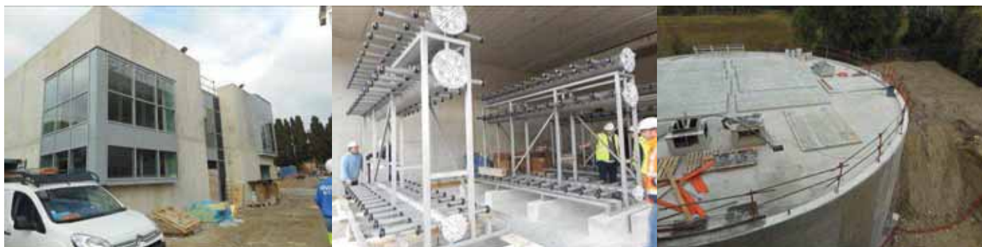
Photos des travaux en cours en janvier 2016 - de gauche à droite : bâtiment administratif, salle des membranes, bassin de stockage
