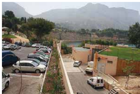
Station d'épuration de Cassis
