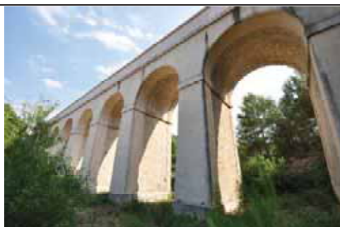
Aqueduc Jacourelle - La Roque d'Anthéron
