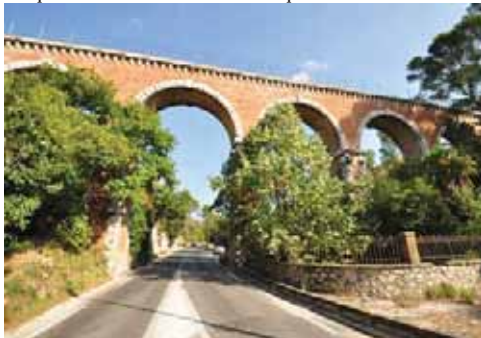
Aqueduc de la Clue - Marseille
