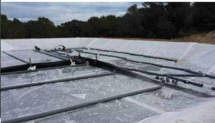
Photos des travaux en cours en décembre 2016 - de
