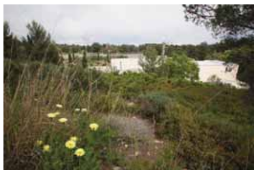
Station d'épuration de Carry-Sausset
