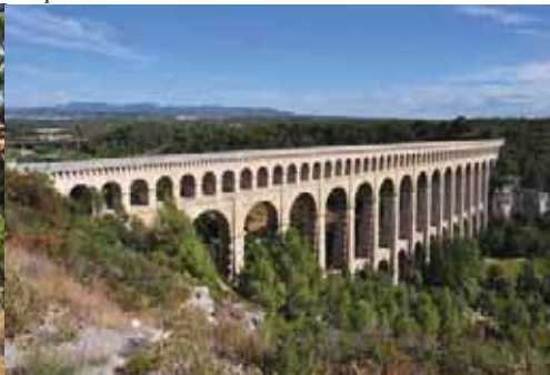
Aqueduc de Roquefavour - Ventabren
