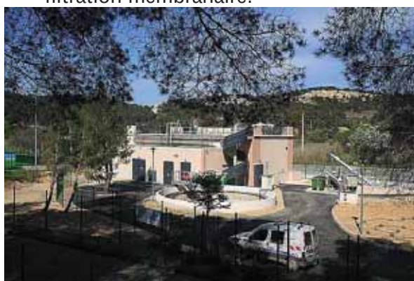
Station d'épuration d'Ensues-la-Redonne
