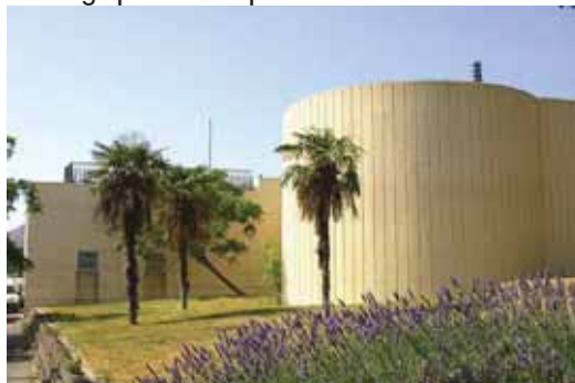
Station d'épuration de La Ciotat
