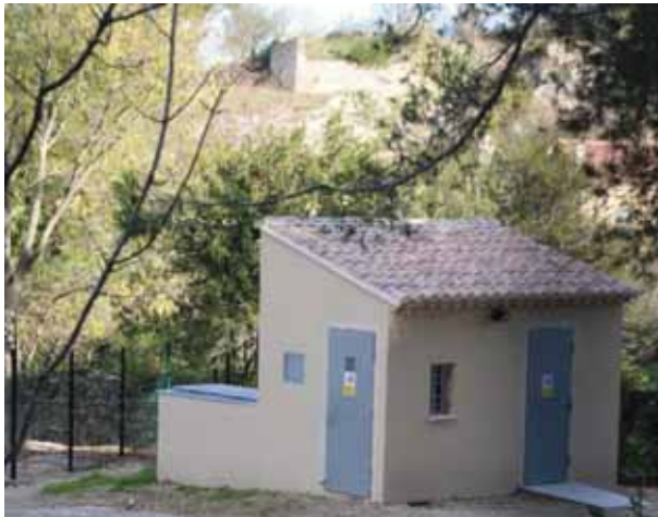
Forage Saint-Sauveur (Alleins)
