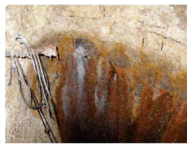
Le ferrailage apparent
