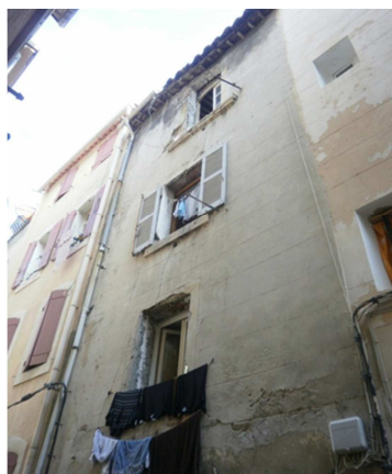
Immeuble situé 4, rue Porte Baussenque – (2 e ) –
