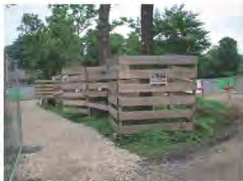
Mise en place de corsets de protections lorsque le passage des engins peut être très proches des arbres
