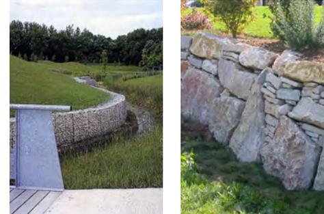
Des murs de soutènement pour les bassins...gabions ou enrochements non jointés selon la gestion et l'entretien
