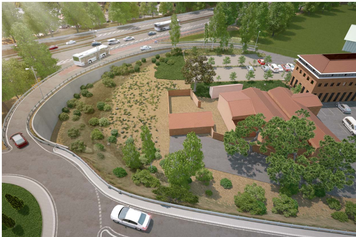
VR-TC – Entrée autoroute A51 au niveau de la RD9 – Aix-en-Provence
