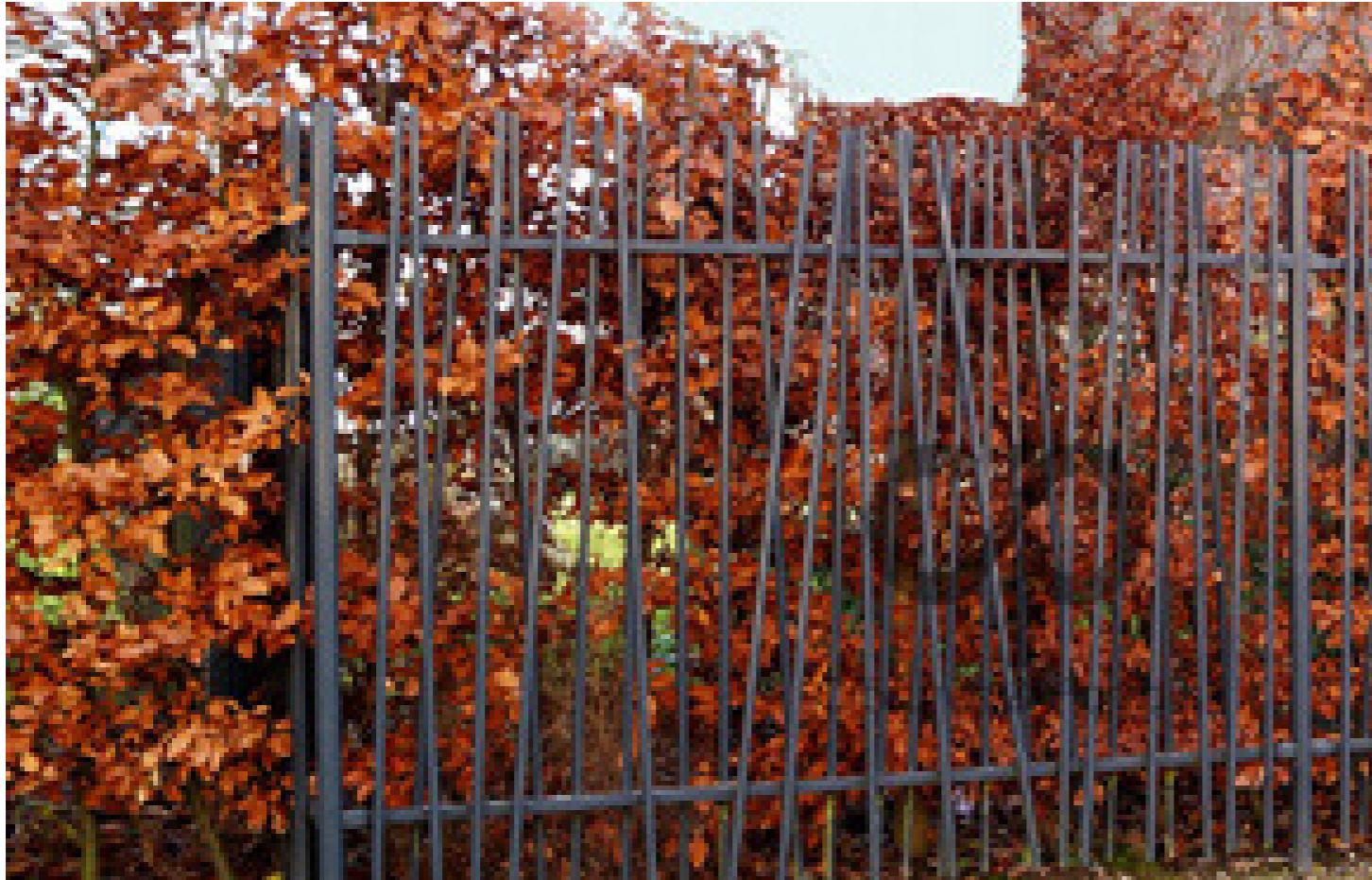
Clôture 1 Barreaudage type «bambou» Clôture opaque ( ponctuellement) - terre ou pierre (sans enduit- couverture pierre ) avec passage hydraulique lorsque nécessaire
