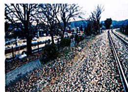
Ancien chemin des Tuileries ou droit de la société du Canal de Provence
