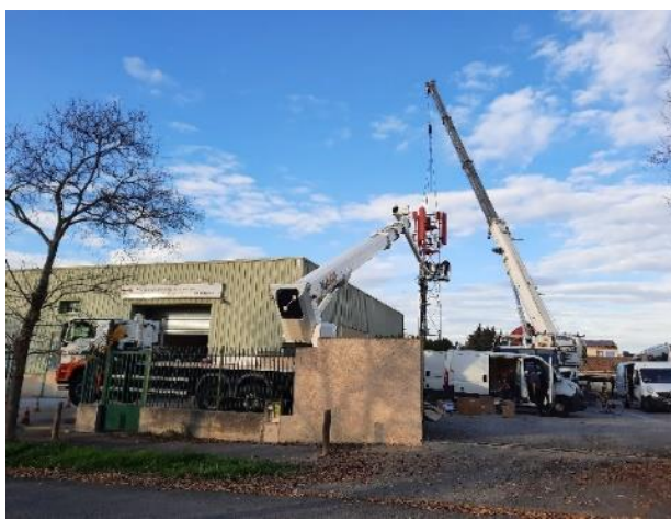
Changement de l'antenne de télécommunication (Orange France) Centre opérationnel de collecte
