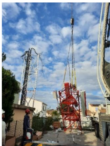
Changement de l'antenne de télécommunication (Orange France) Centre opérationnel de collecte
