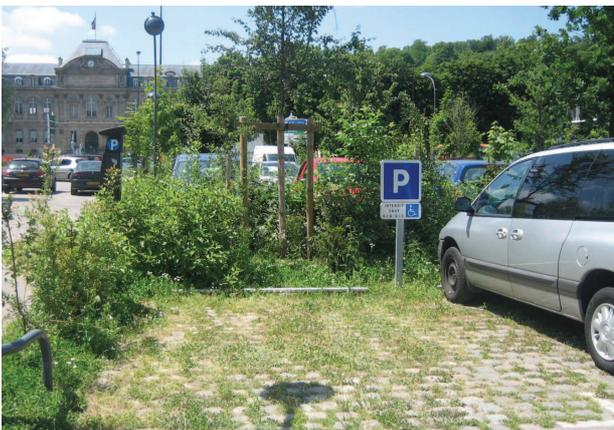
Stationnement de véhicules au sol perméable
