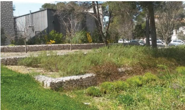
Type de gabions permettant de traiter les différences de dénivélé
