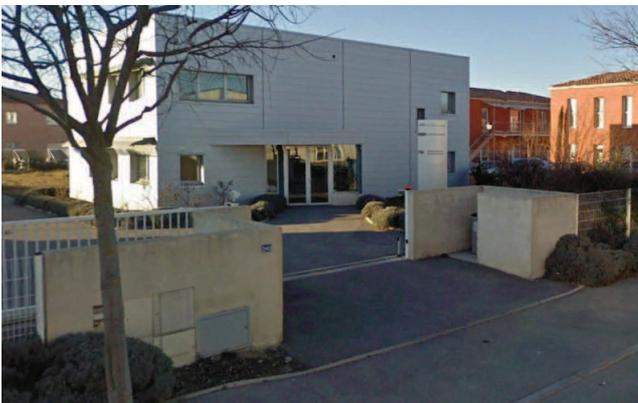
Moins honéreux, le portail en maçonnerie doit être enduit avec soin le local poubelle est intégré et reste discret, éviter les coffrets en façade sur voie
