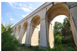
Aqueduc Jacourelle La Roque d'Anthéron
