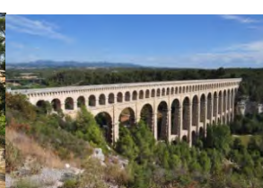
Aqueduc de Roquefavour Ventabren
