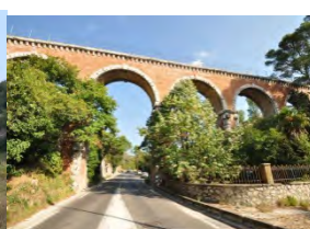
Aqueduc de la Clue Marseille
