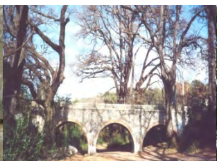
Aqueduc des Lignières Aubagne
