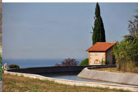
Canal de Marseille
