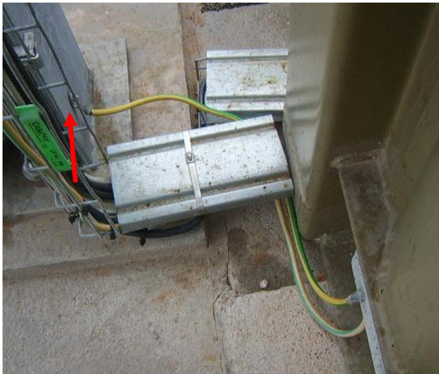
Photo 3a – Exemple de mise à la terre grillage plateforme
