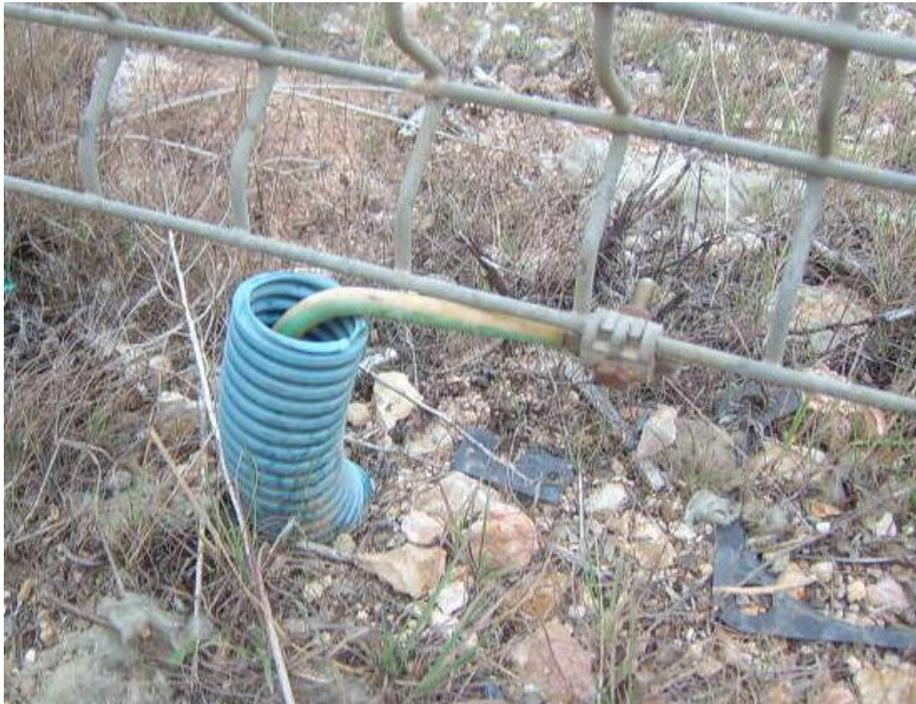
Photo 3B – Exemple de mise à la terre des abris transfos
