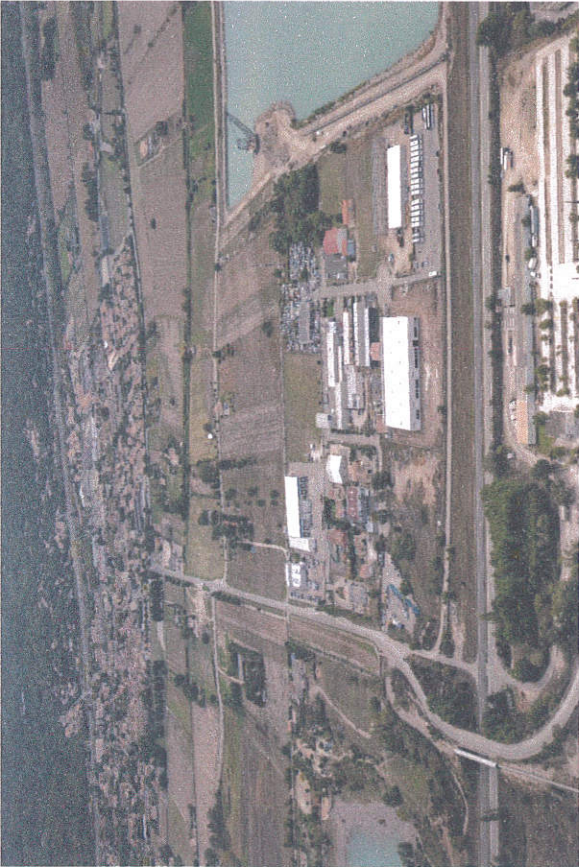
Vue aérienne Nord > Sud
