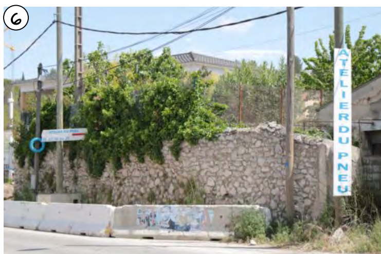
Préenseignes sur poteaux électriques
