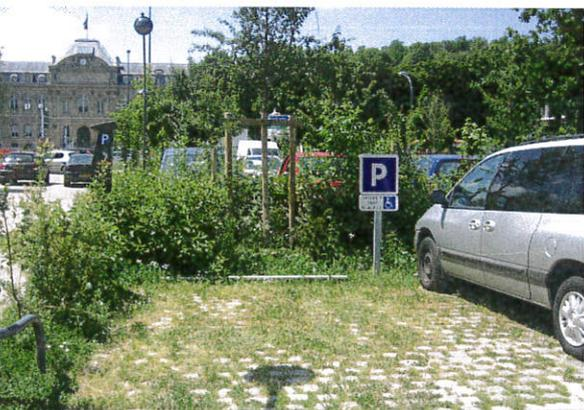
Stationnement de véhicules au sol perméable
