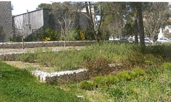
Type de gabions permettant de traiter les différences de dénivelé
