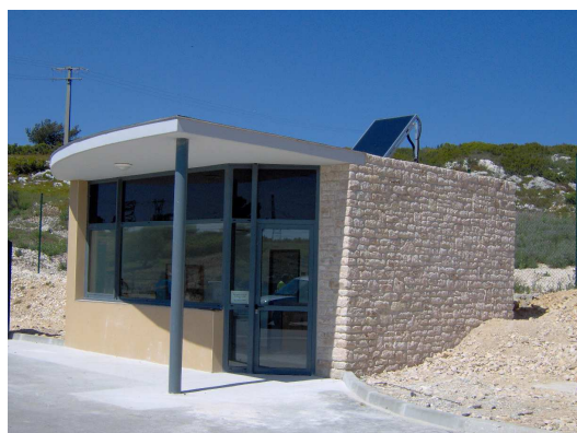
Bâtiment d'accueil – Déchèterie du Vallon du Fou
