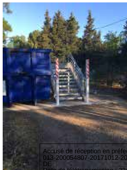
Réfection de l'escalier du point vert de Puyricard
