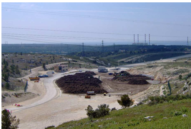
Plateforme de compostage en exploitation
