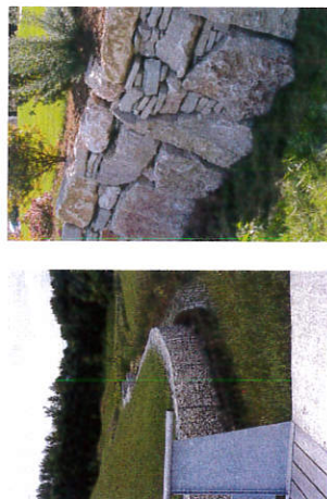
Des murs de soutènement pour les bassins... gabions ou enrochements non jointés selon la gestion et l'entretien
