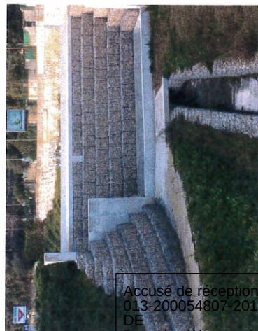
Intégration paysager dans la pente, structure béton ou bien adaptation au terrain par des enrochements...
