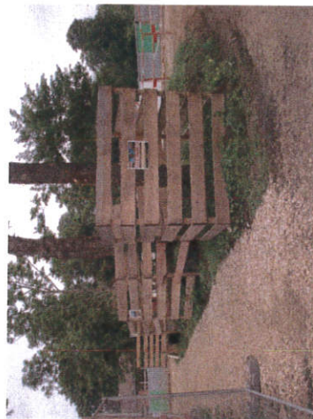
Mise en place de corsets de protections lorsque le passage des engins peut être très proches des arbres
