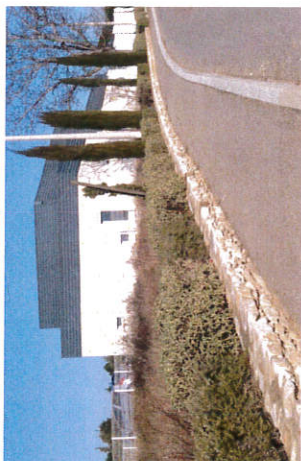
Muret en pierre pour gérer les ressauts de terrain générés par les aménagements de la ZAC
