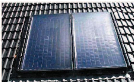
**Figure 9 : Capteurs solaires thermiques installés en toiture terrasse avec plots de fixation et Capteurs solaires thermiques intégrés à une toiture inclinée**
