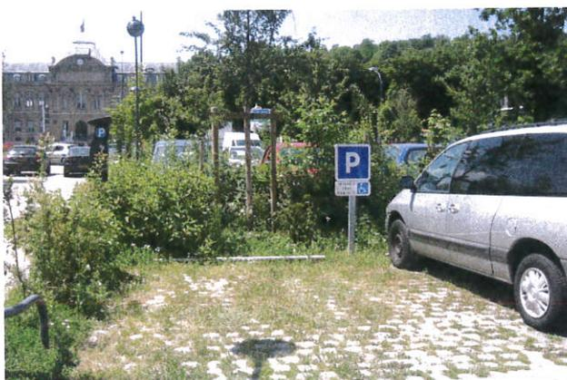
Stationnement de véhicules perméable
