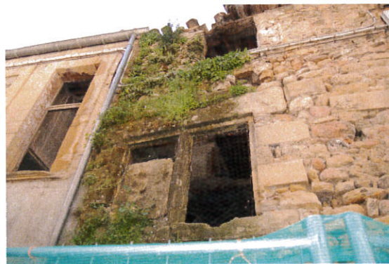
Bâtiment soumis aux travaux de mise en sécurité
