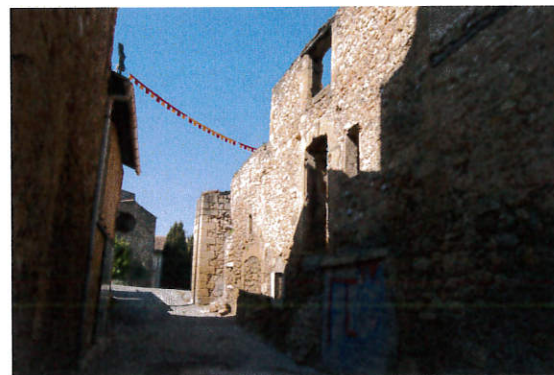
Bâtiment en ruine - Accès condamnés au public
