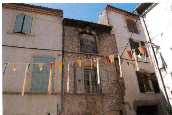
Façade d'origine non restaurée
