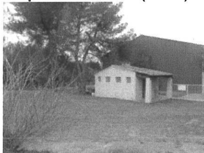
Bâtiment sanitaires (D)
