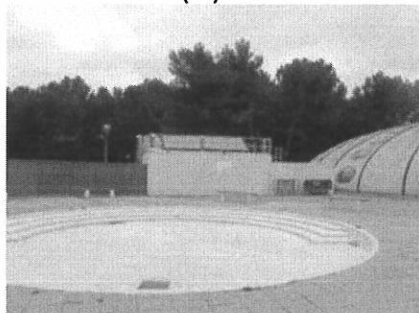
Locaux techniques (E)
