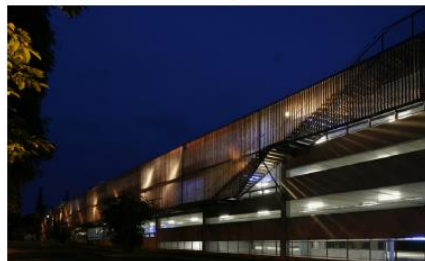
Parking silo, Valencienne - Hubert et Roy architectes
