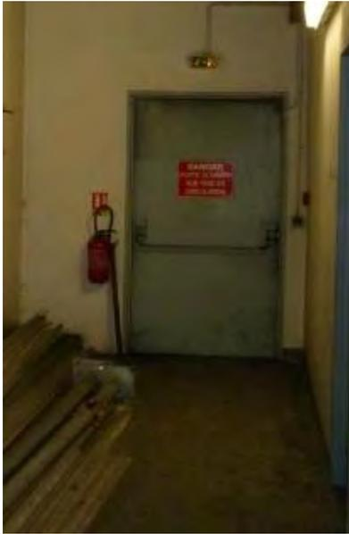
Afin de pouvoir couper l'alimentation HT de l'usine électrique Cantini (arrivée principale haute tension du distributeur Enedis), un système d'arrêt d'urgence a été installé à l'entrée du local. Cette installation fait suite au retour d'expérience de l'incendie de l'usine en 2018. (Problématique de réactivité de coupure générale)
