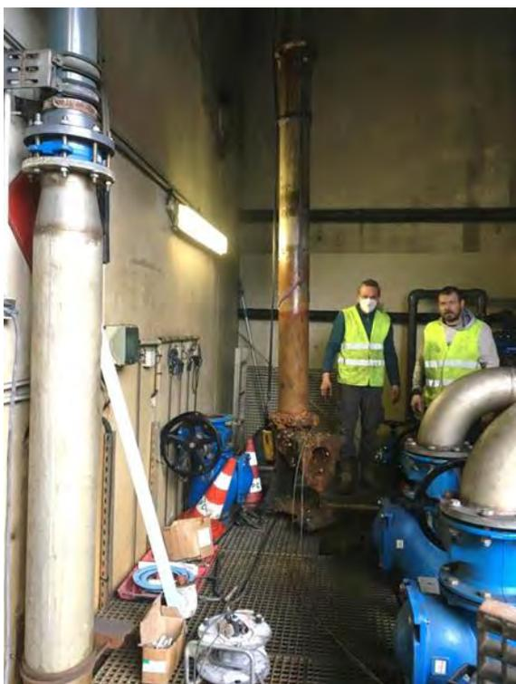
Les pompes de la station de relevage Carénage ont subi un vieillissement prématuré (acidité de l'eau, configuration du bassin, ...).
