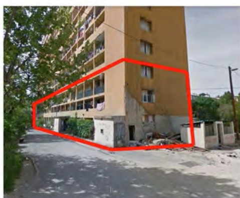
CONDAMNER L'ENSEMBLE DES BAIES (Portes et fenêtres)
