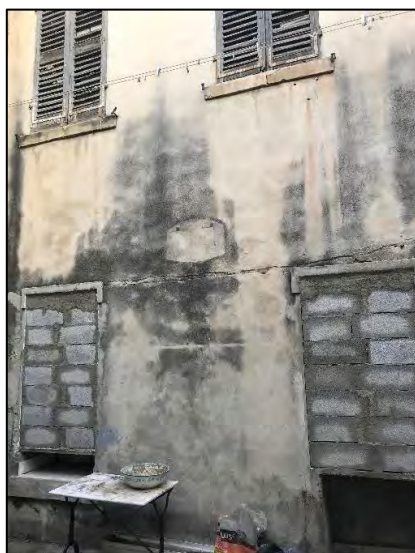
Exemple de travaux de sécurisation au 7 rue Séraphin, 13015
