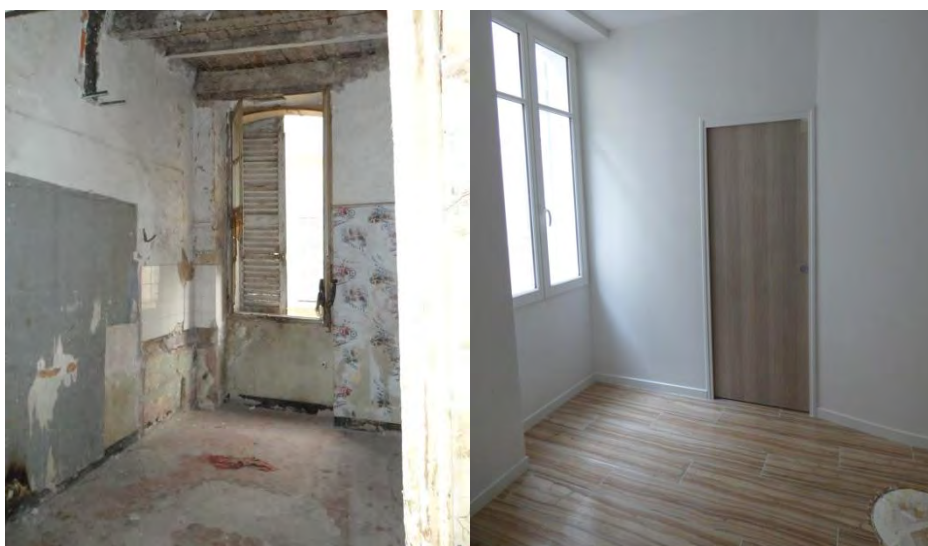
Immeuble situé 17, rue du Musée (1 er )– vendu avec cahier des Charges en 2016 Avant / après travaux
