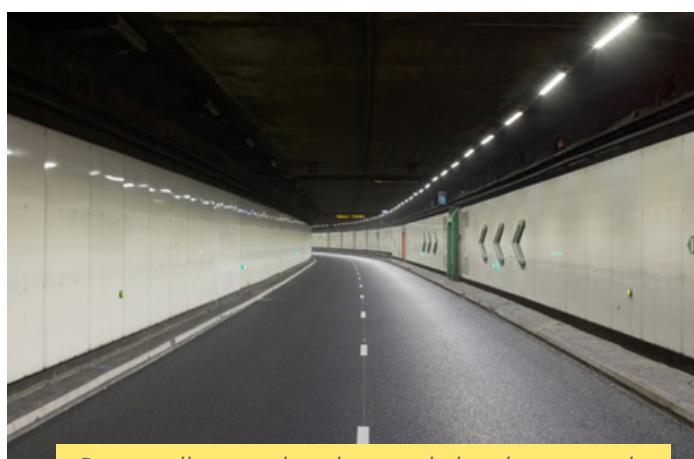
Renouvellement des plaques de bardage tunnel
