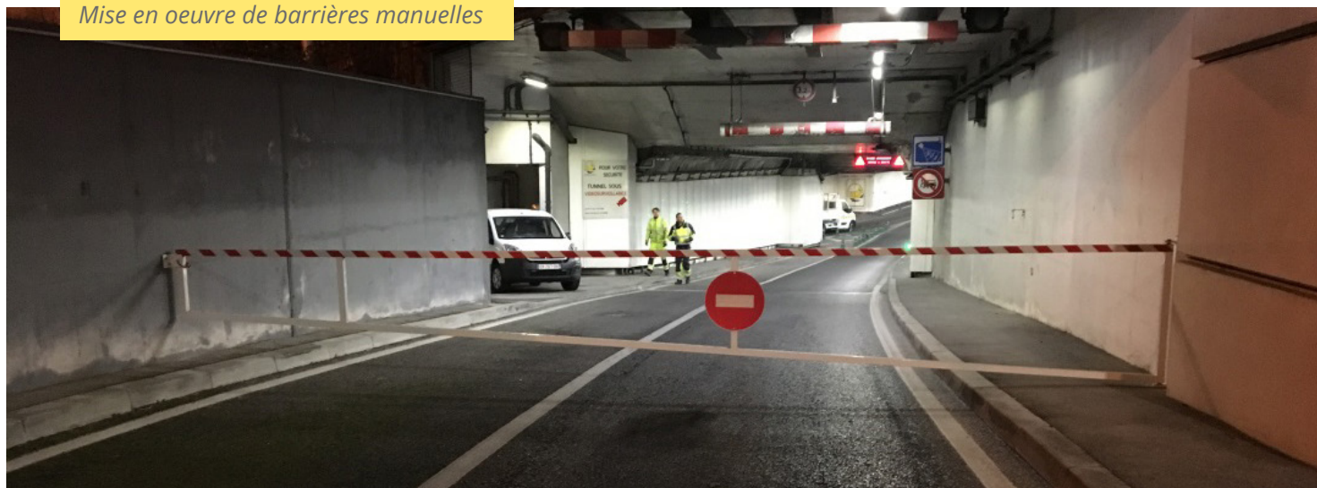
Sécurisation des accès aux stations de pompage
